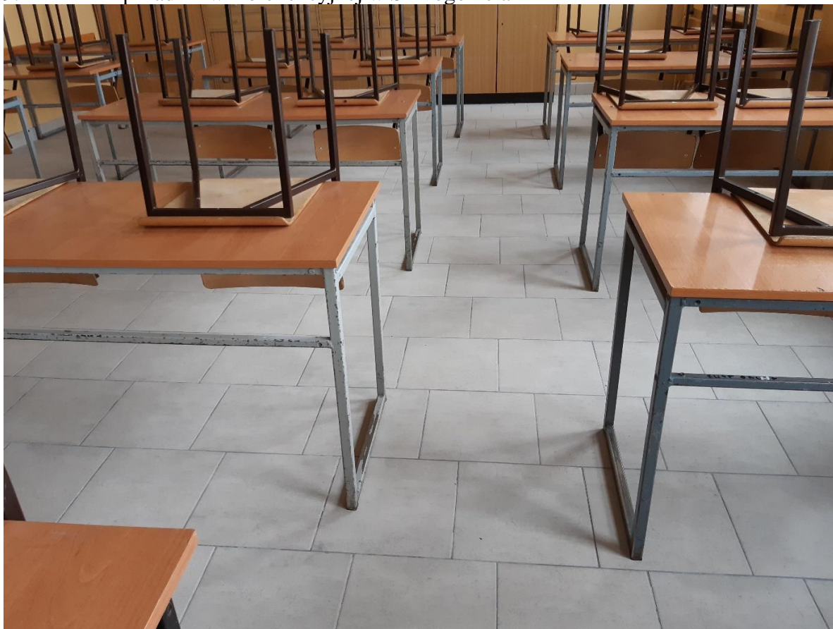
9. Ułożenie posadzki w izbie lekcyjnej w SP Pogorzela
