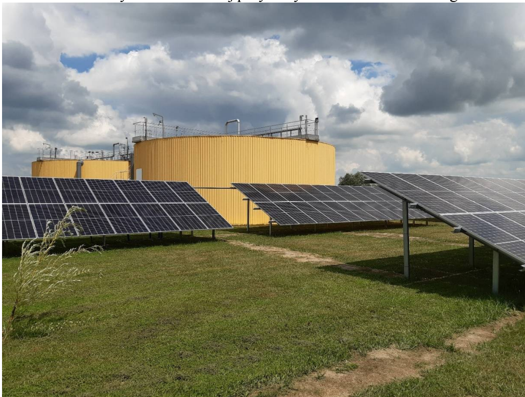
15. Budowa farmy fotowoltaicznej przy oczyszczalni ścieków w Pogorzeli
